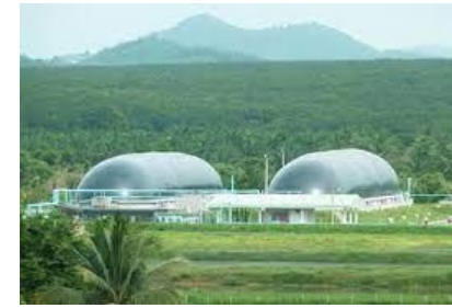
Biogas Energy: 335 MW
