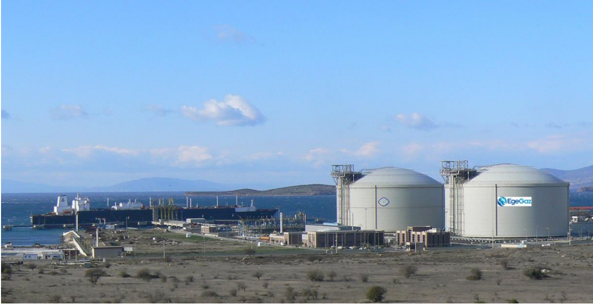
STORAGE of LNG in TANKS
